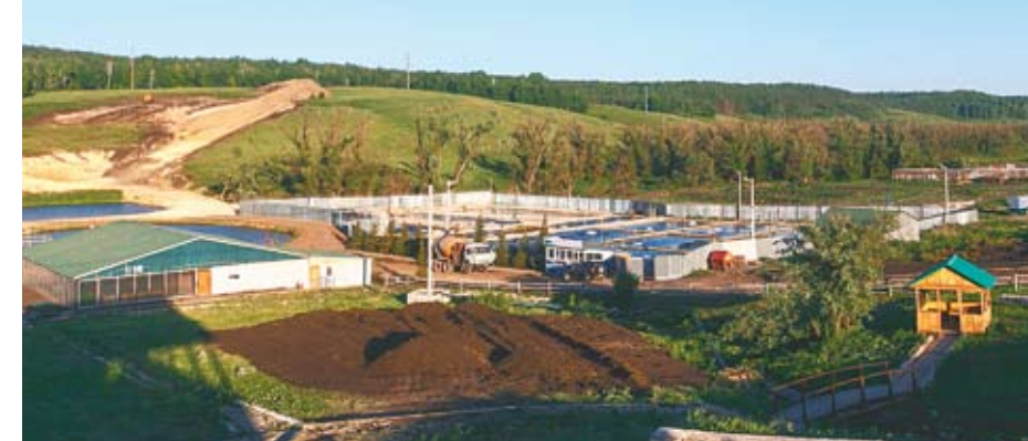
Строительство канатного подъёмника
