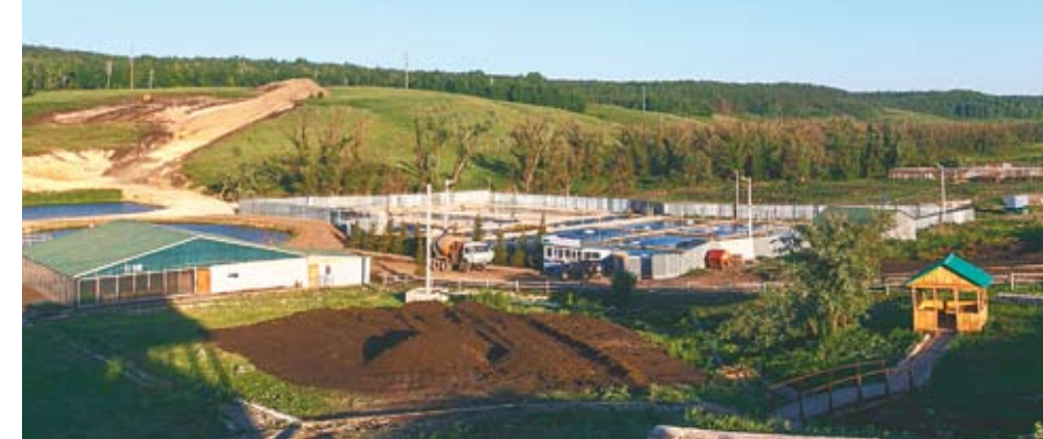
Строительство канатного подъёмника
