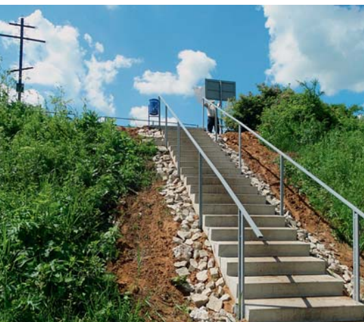
Родник села Угорье. Новый лестничный марш
